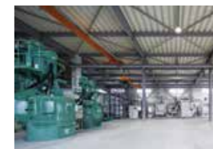
真空浸炭工場
