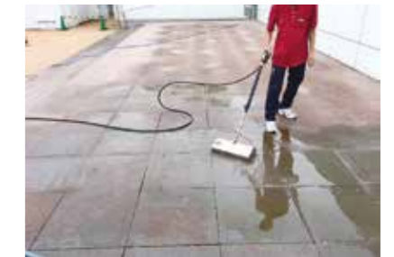
高圧洗浄機による清掃
